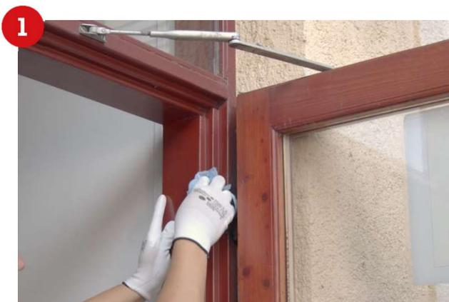
Aufgrund des speziellen Profilgummis, hat das Dichtungsband eine hohe Witterungsbeständigkeit und ist für Fenster und Türen geeignet. Der Untergrund sollte vor der Anbringung des Dichtungsbandes gut gereinigt werden.
