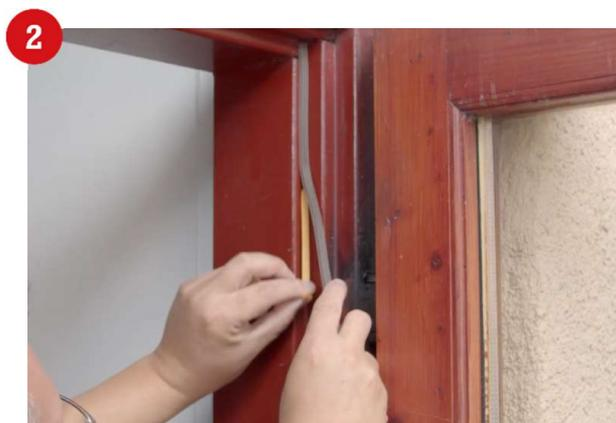
Selbstklebende, in weiß oder braun und in verschiedenen Spaltgrößen verfügbar. Profil „E“ – Spaltgröße: 1-3,5mm, Profil „P“ – Spaltgröße: 2-5mm.
